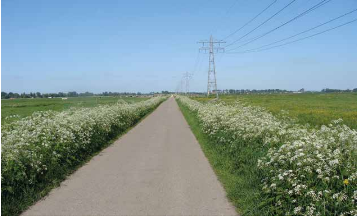
Vanaf de jaren vijftig overspande een tussen Dordrecht en Klaaswaal aangelegde 50 KV hoogspanningsleiding Het Oudeland van Strijen van oost naar west, Molenweg, NL in Beeld-René Koster.
